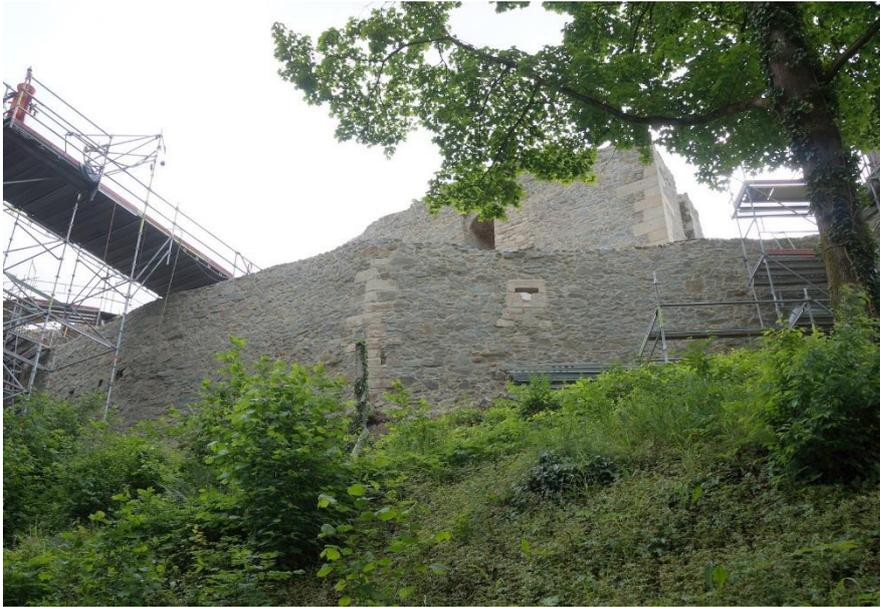
Inzwischen ist die Westmauer des Berings der Hohenberneck fertiggestellt und das Arbeitsgerüst abgebaut. Die gefährliche Ausbauchung durch Wurzeln von drei Eschen ist beseitigt und ebenso sämtliche weitere Mauerschäden. Die Arbeiten laufen aktuell voll nach Zeitplan.
